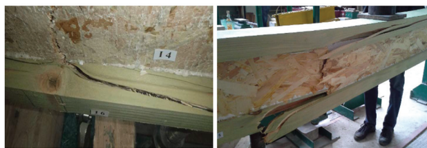
Рис. 4 Места разрушения балок Б-1 и Б-2
